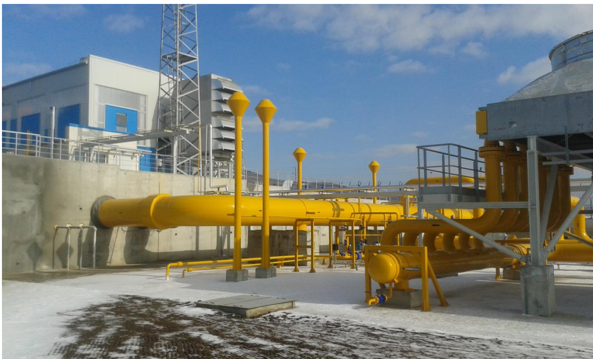
Компресорна станция „Лозенец“
