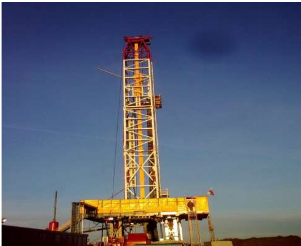
ПГХ „Чирен” – Сондажна кула по време на прокарване на нов експлоатационен сондаж
