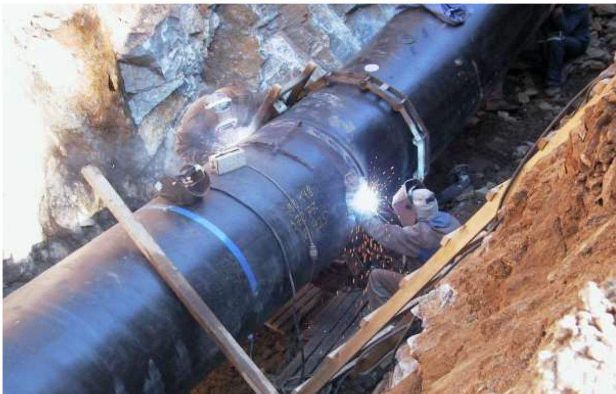
Заваряване на газопровод високо налягане
