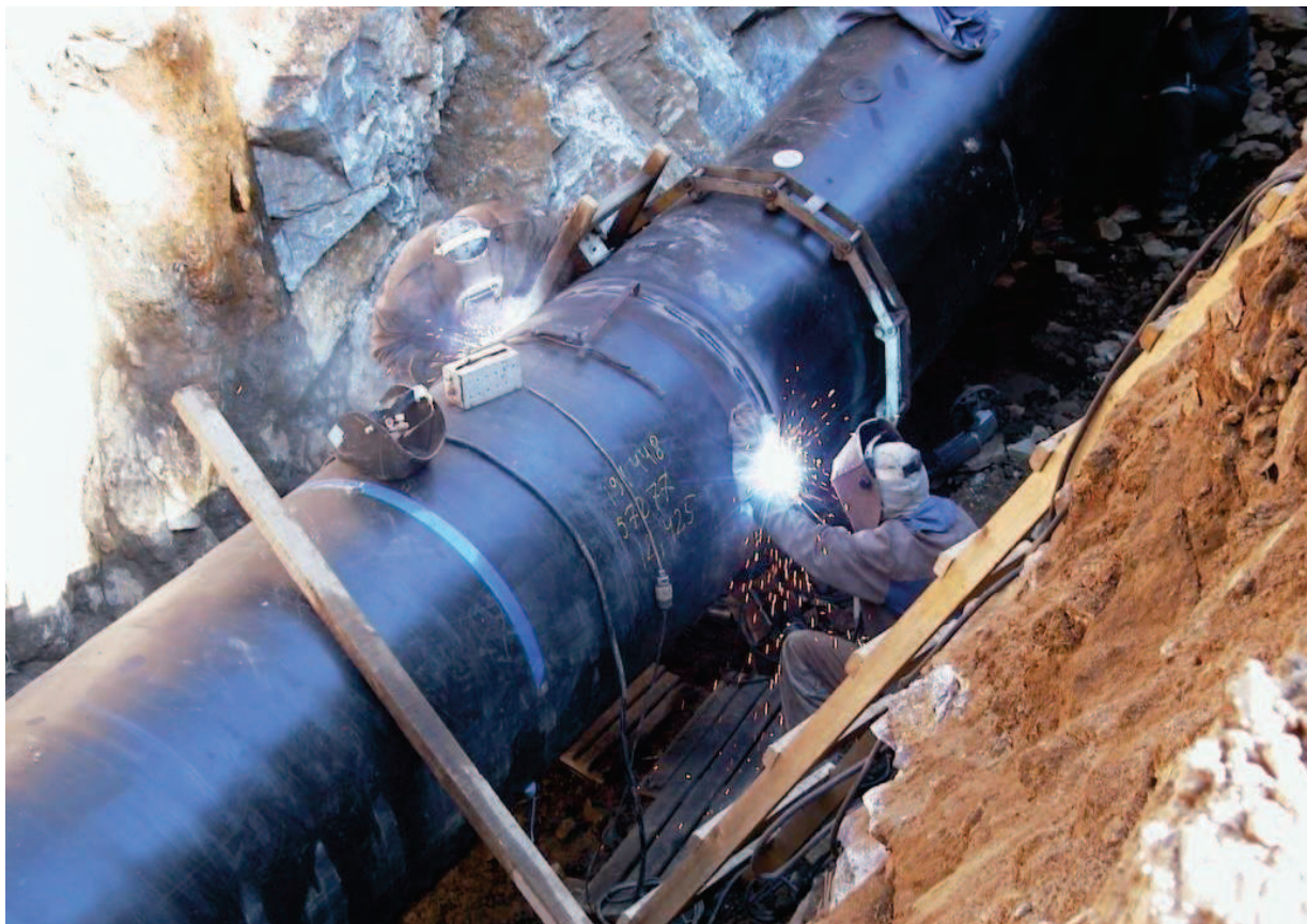
Заваряване на газопровод високо налягане
